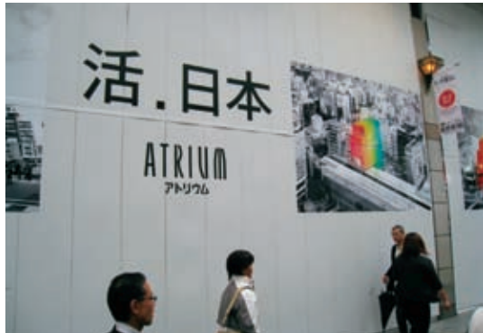
仙台車站周邊施工圍籬
